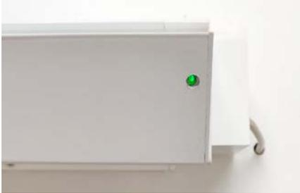
4. Lorsque tous les composants sont connectés, « l'Installer mode » peut être désactivé en appuyant sur « INST » sur le DucoBox ou en appuyant sur les quatre touches en même temps. Les LED sur tous les composants s'arrêteront de clignoter et le système passera en « mode utilisateur ».
